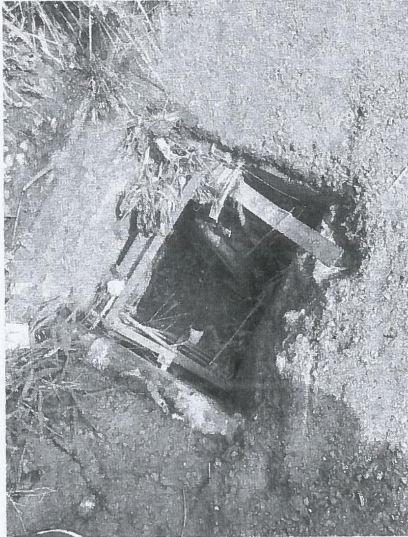
Um dos captadores de água da rua Caminho Novo está danificado e sem grade de proteção, correndo o risco de ocasionar acidente com as pessoas que transitam por ali.
