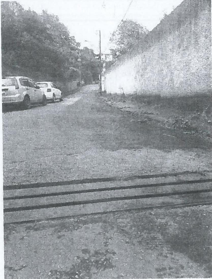
Na rua do Caminho Novo, aproximadamente 350 metros, possui somente três captadores. Por ser uma rua extensa e com forte declive, a água pluvial passa com alta velocidade no coletor, sendo sua eficiência quase nula. O excesso de água vai para a rua do Campinho.
