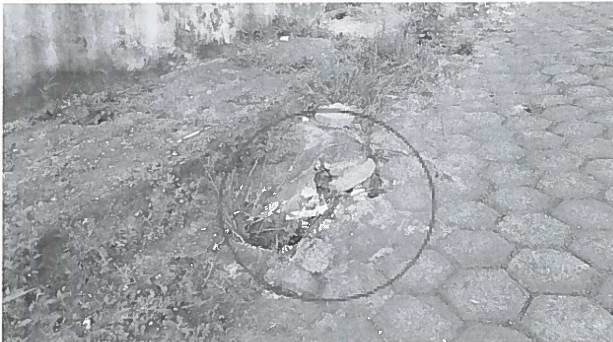
Registro atual do bueiro. 24/04/2023
