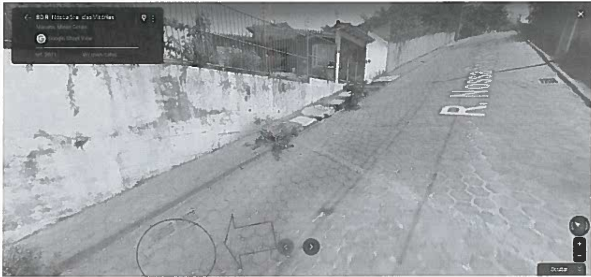
Bueiro situado de frente ao nº 80.
