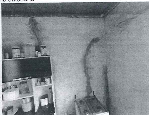
Umidade na alvenaria
