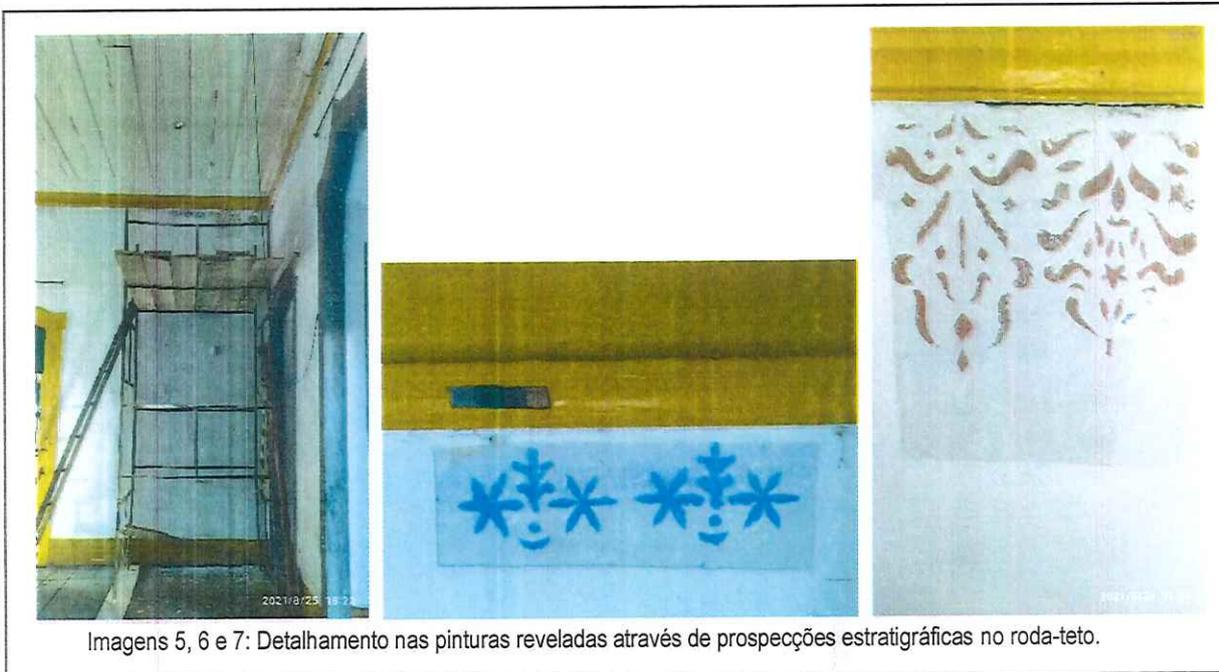
Imagens 5, 6 e 7: Detalhamento nas pinturas reveladas através de prospecções estratigráficas no roda-teto.
