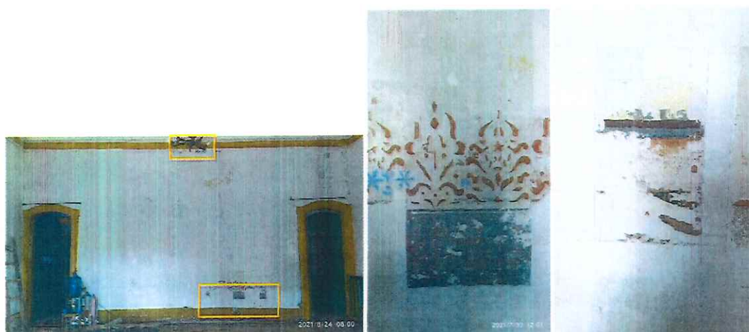
Imagens 2, 3 e 4: Detalhamento nas pinturas reveladas através de prospecções estratigráficas no barrado da sala.
