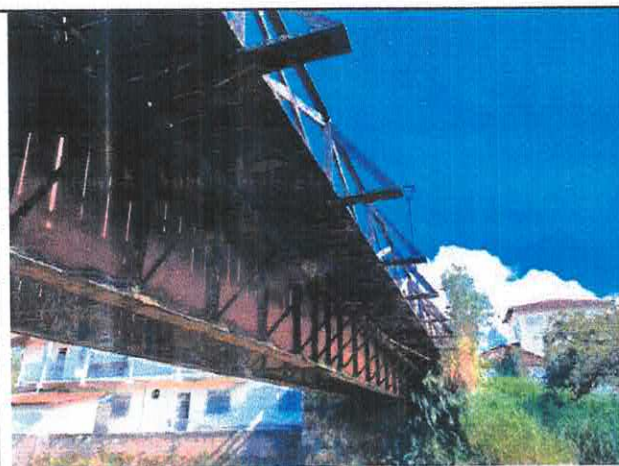
Imagem 5: Vista do vigamento principal
