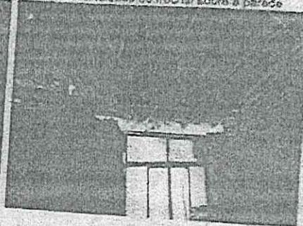
Detalhe da ruptura do frechal
