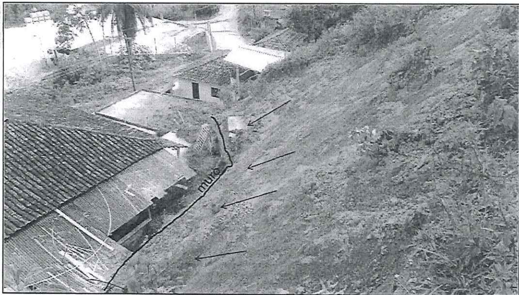
Figura 07: Detalhe do muro, responsável por minimizar o deslocamento de parte do maciço.
