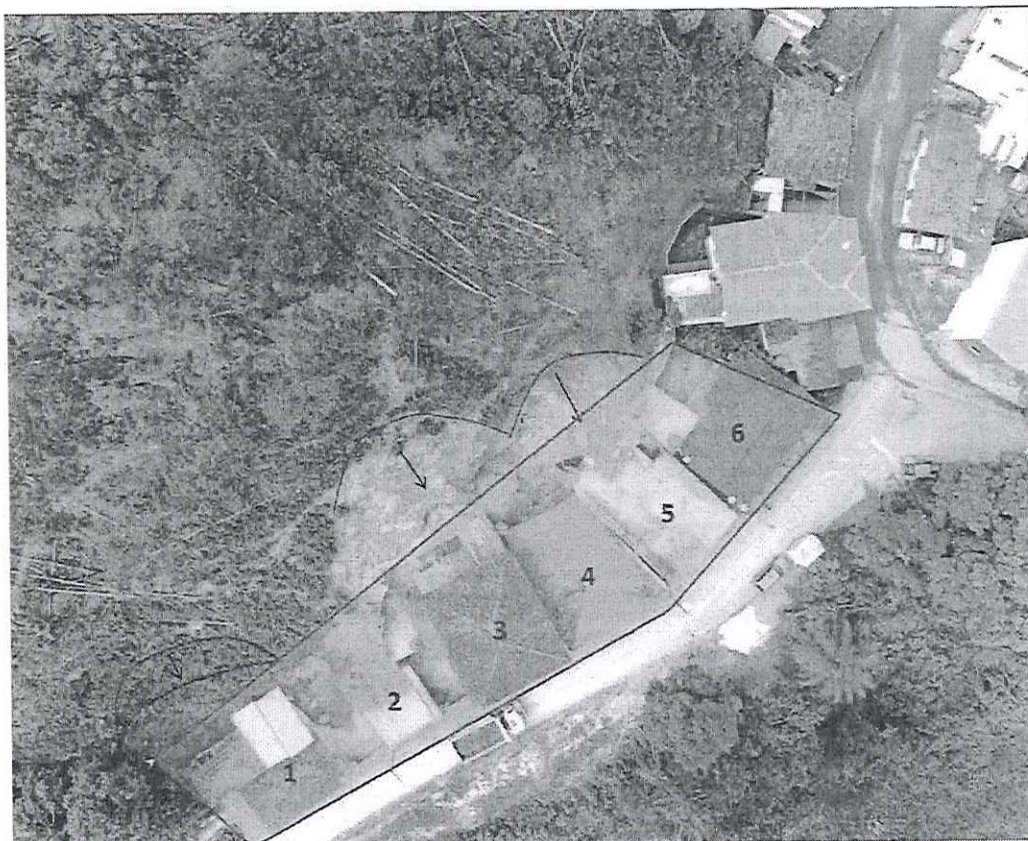
Figura 08: Delimitação das edificações dentro área de risco de nível crítico, onde há ameaça a vida humana.
