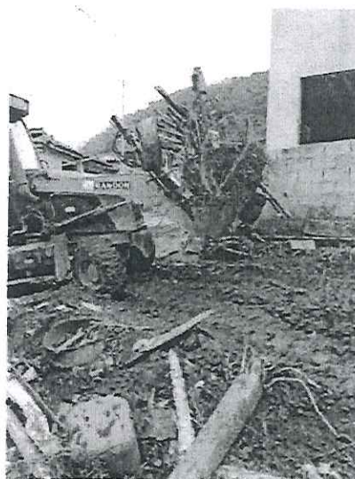
RETIRADA DE ENTULHOS
