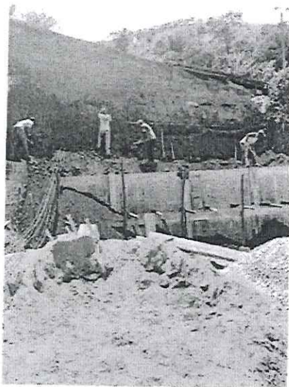
MURO II SOBRE MURO I – FERRAGEM E DA FUNDAÇÃO
