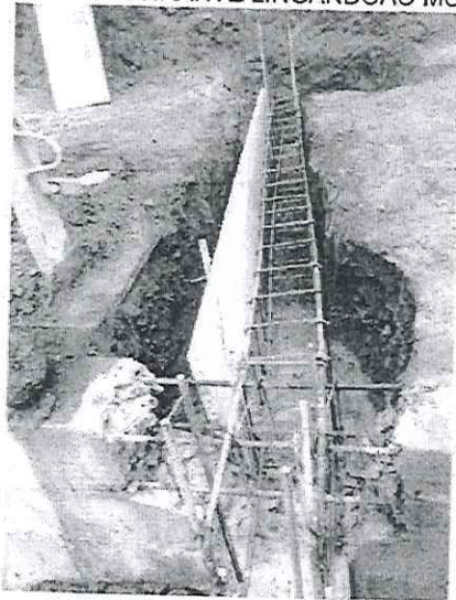
MURO II VIGA TIRANTE LINGANDO AO MURO I
