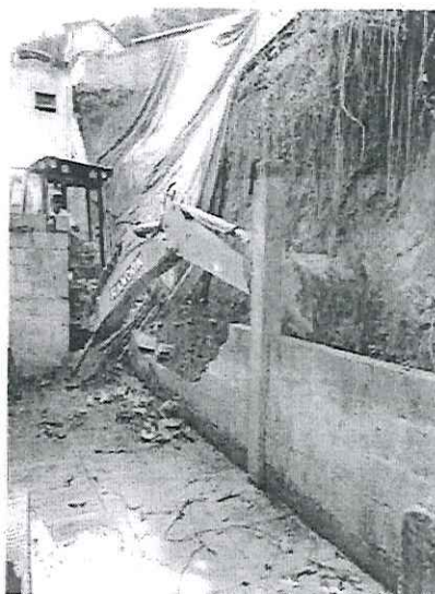
DEMOLIÇÕES DE MURO EXISTENTE
