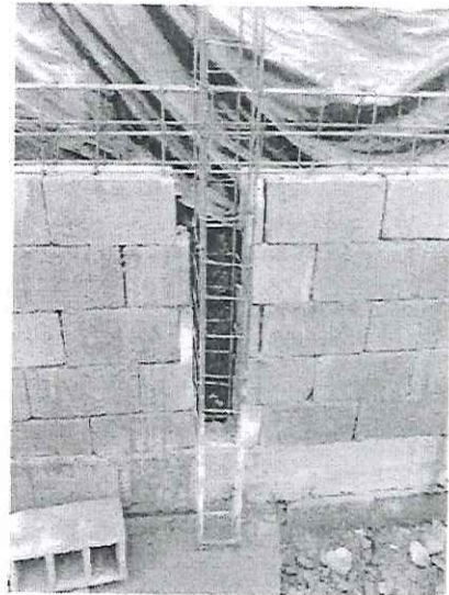
MURO I – PARTE INFERIOR - FORMA, ALVENARIA PILARES E VIGAS
