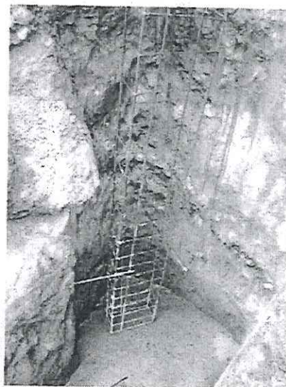
MURO I – PARTE INFERIOR - CONSTRUÇÃO DA FUNDAÇÃO
