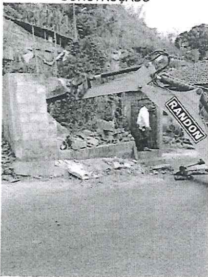
ÁREA A SER DEMOLIDA E LIMPA PARA A CONSTRUÇÃO
