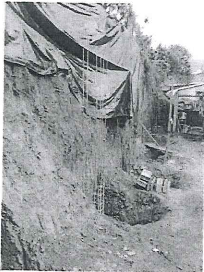
MURO I – PARTE INFERIOR - ESCAÇÃO PARA CONSTRUÇÃO DO MURO
