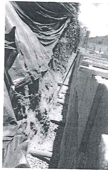
MURO II DRENO EM BRITA
