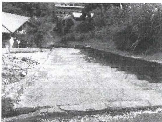
Escada de acesso da Quadra do Rosário à Rua Cerejeira
