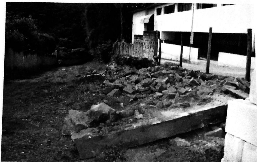
Vista lateral do muro
