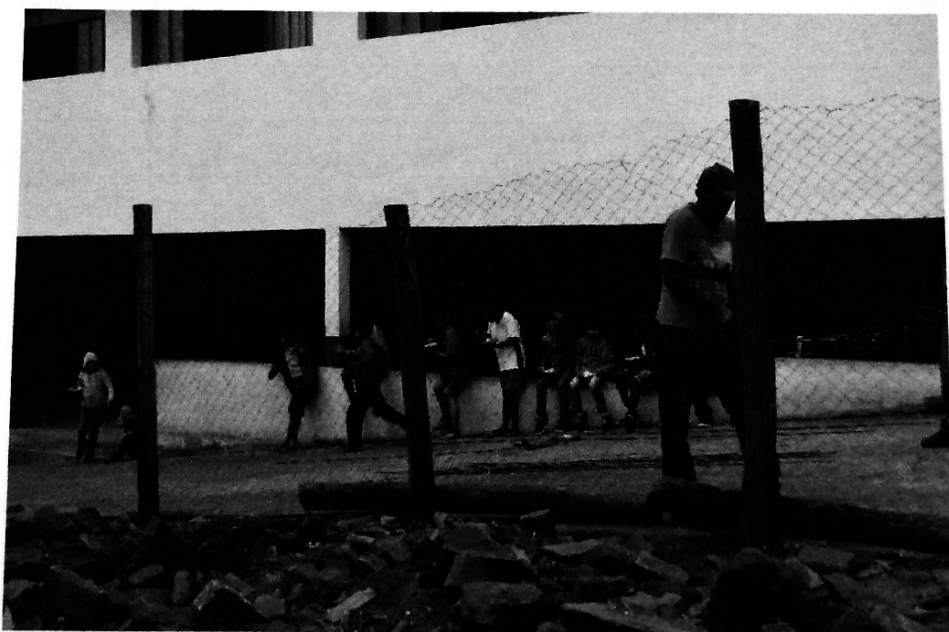
Colocação da tela após derrubada de parte do muro
