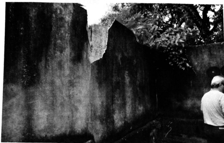
Muro não derrubado
