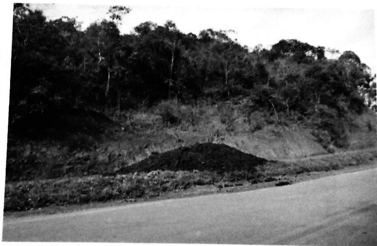
Material asfáltico depositado para pavimentação da pista de caminhada
