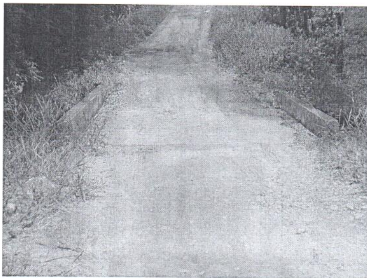
Ponte da Rua Cuiabá, subdistrito Goiabeiras
