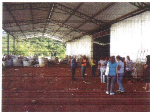
Foto 5.83 – Galpão da CAMAR
