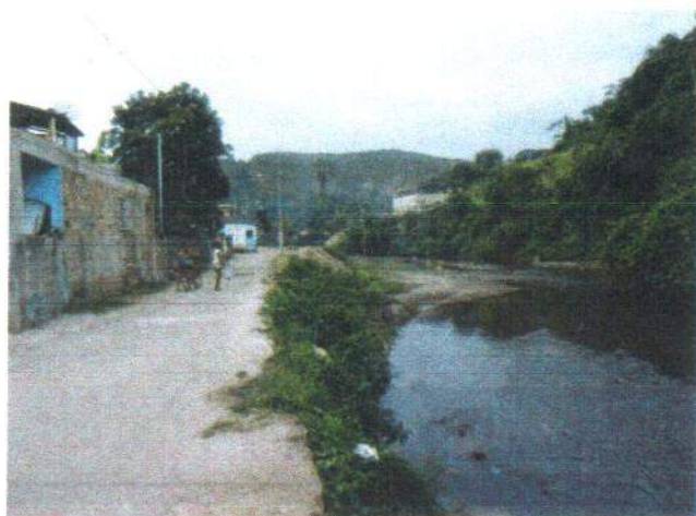
Foto 5.106 – Rua Beira Rio (1)
