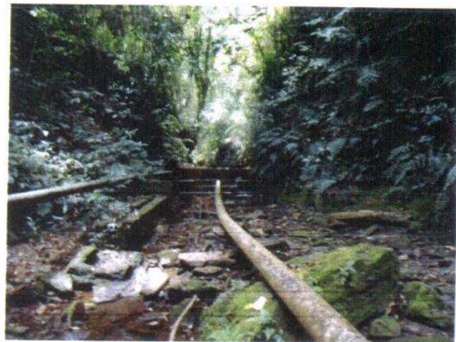
Foto 5.6 – Adutora do sistema (2)
