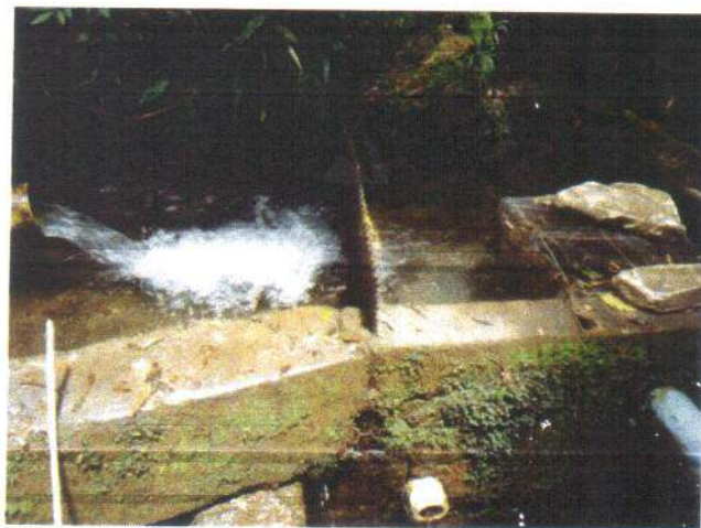
Foto 5.4 – Barragens de nível (2)
