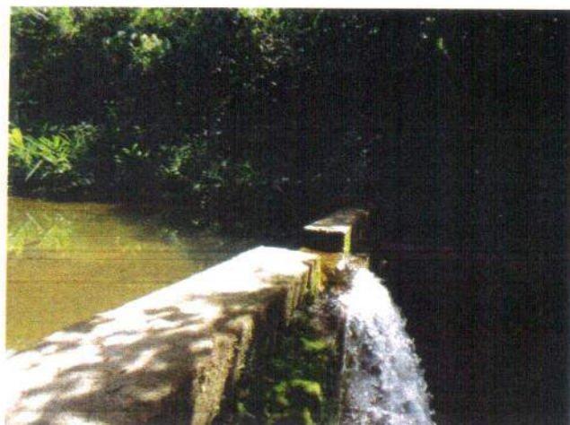
Foto 5.18 – Barragem de nível
