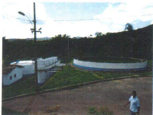
Foto 5.19 – Vista da ETA Mata do Seminário (1)
