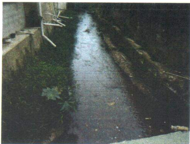
Foto 5.70 – Lançamento de esgoto in natura em afluente Ribeirão do Carmo
