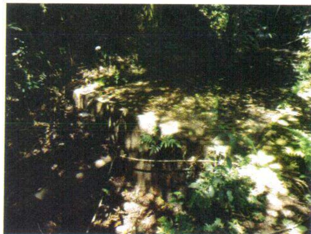
Foto 5.10 – Captação no Córrego Del Rey (2)
