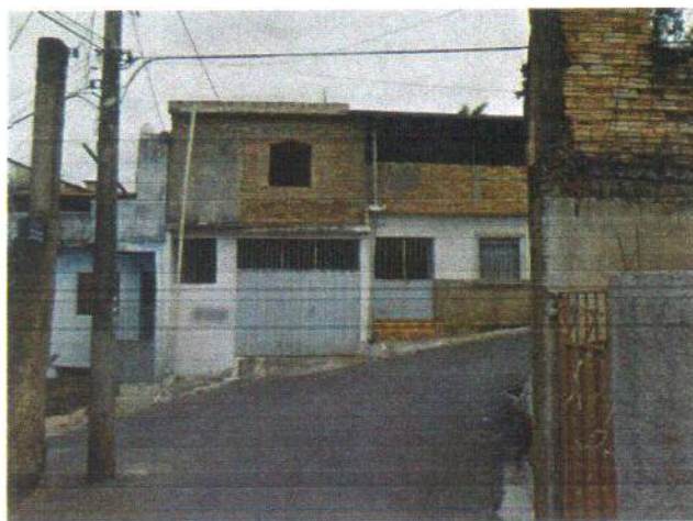
Foto 5.85 – Travessa São Gonçalo (2)
