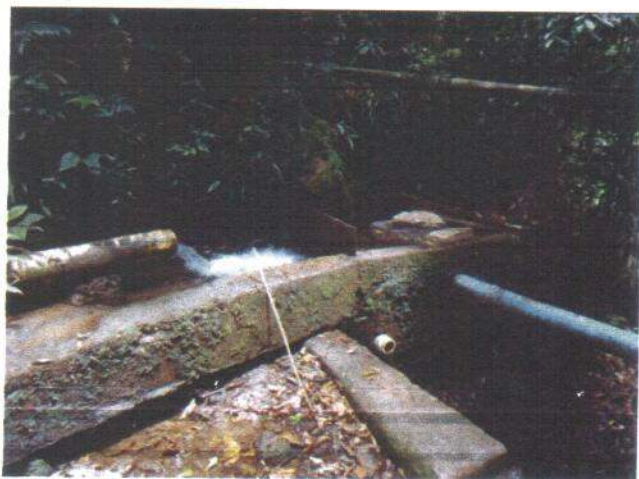
Foto 5.3 – Barragens de nível (1)
