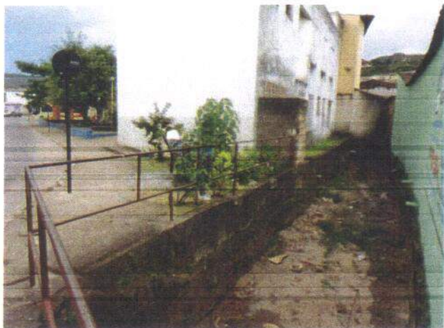
Foto 5.104 – Canal próximo à Praça do Barro Preto
