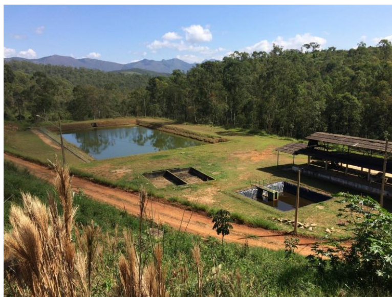
Figura 61 – Sistema de tratamento de chorume do aterro sanitário Fonte – CAVO, 2017
