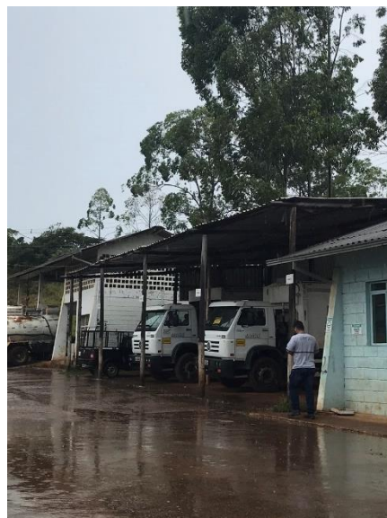
Figura 59 – Oficina do aterro sanitário Fonte – Acervo Ambiência, 2019
