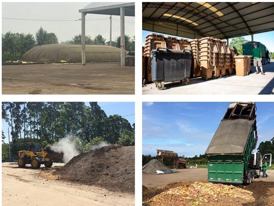
Figura 3 – Sistema Composul. Compostagem por leiras estáticas, aeradas e encapsuladas por membranas semi-permeáveis.
