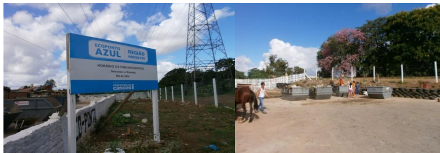
Figura 6 – Ecoponto para recebimento de RCCV em Canoas/RS Fonte – FESP, 2014
