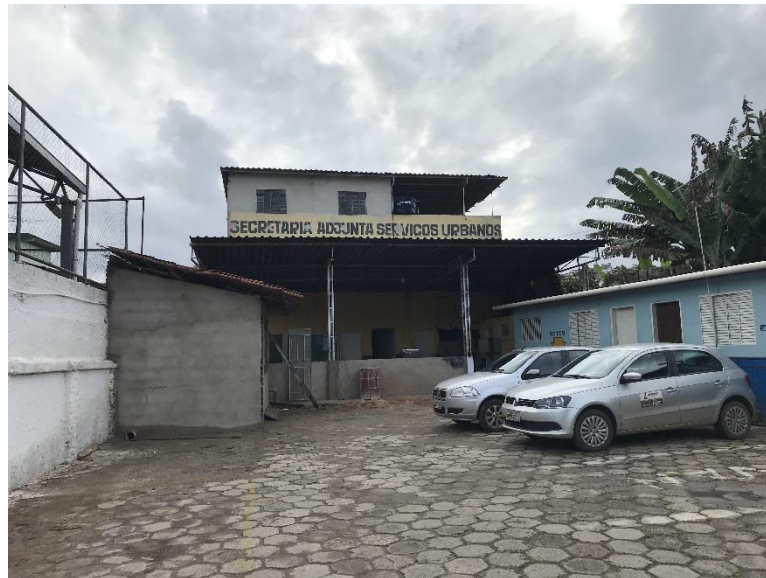
Figura 53 – Secretaria de Obras e Gestão Urbana Fonte – Acervo Ambiência, 2019
