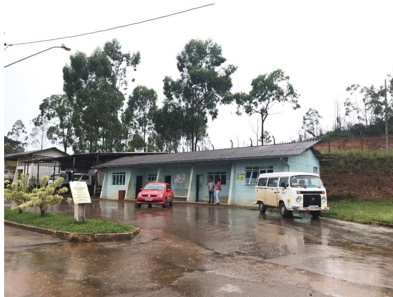
Figura 58 – Ponto de apoio do aterro sanitário Fonte – Acervo Ambiência, 2019
